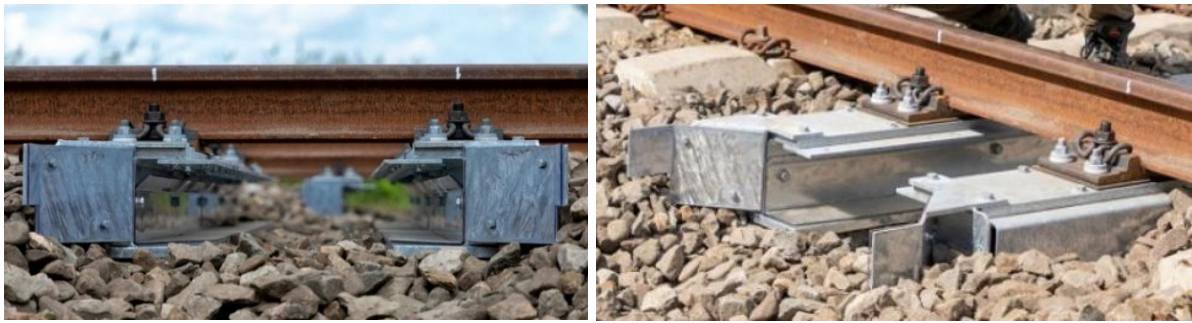
Rys. 6.7. Przejście dla zwierząt w podkładach kolejowych (ang. Sleeper Fauna Passage , nl. Dwarsligger Fauna Passage ) – rozwiązanie eksperymentalne wprowadzone przez ProRail i Movares w rezerwacie przyrody Naardemeer w Niderlandach [218]
