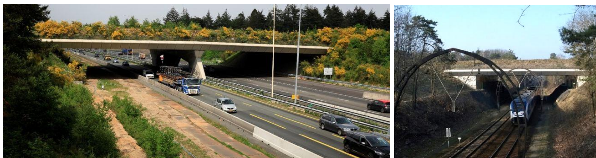
Rys. 6.3. Przejście nadziemne dla dużych zwierząt niedaleko Hilversum w Niderlandach nad autostradą A27 i przebiegającą równolegle linią kolejową Hilversum – Utrecht [214,215]
