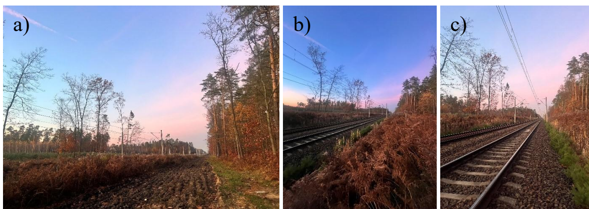
Rys. 9.3. Widok w kierunku Tychów na wysokości 21,9 km a) i b) z otaczających terenów c) z poziomu torów; można zaobserwować niewielki wykop i zasłaniającą tory roślinność
