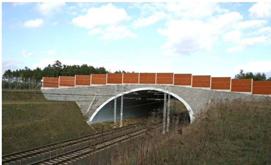
Rys. 6.2. Przejście nadziemne w Rzepin-Kunowice w zachodniej Polsce [212,213]
