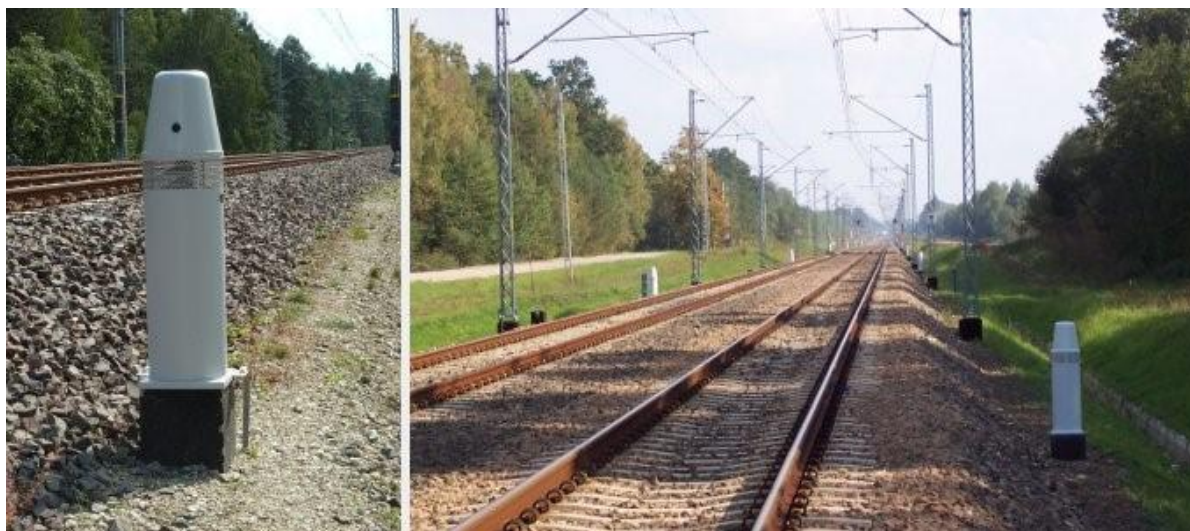
Rys. 6.8. Wygląd i rozmieszczenie urządzeń UOZ-1 wzdłuż torów (materiały producenta [227])
