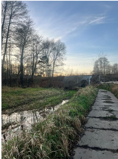
Rys. 9.6. Przepust hydrauliczny nad ciekim, prawdopodobnie koryto boczne rzeki Gostyńki
