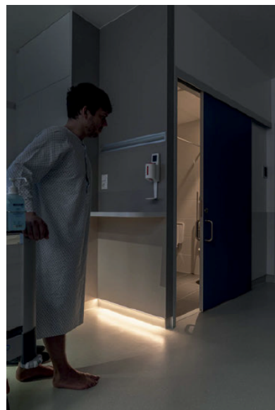
Ryc. 21. System oświetlenia orientacyjnego zastosowany w projekcie KARMIN; źródło: The Patient Room. Planning Design, Layout.
