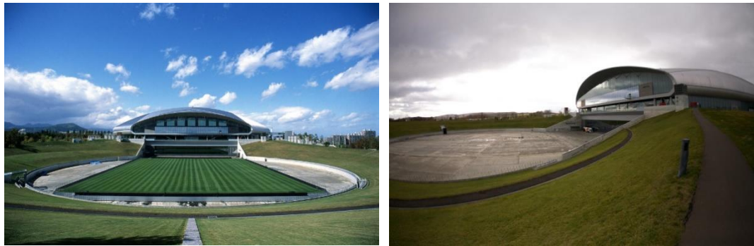
Rys. 4.9 Stadion Sapporo z wysuniętą murawą (lewa strona) oraz ze schowaną (prawa strona)
