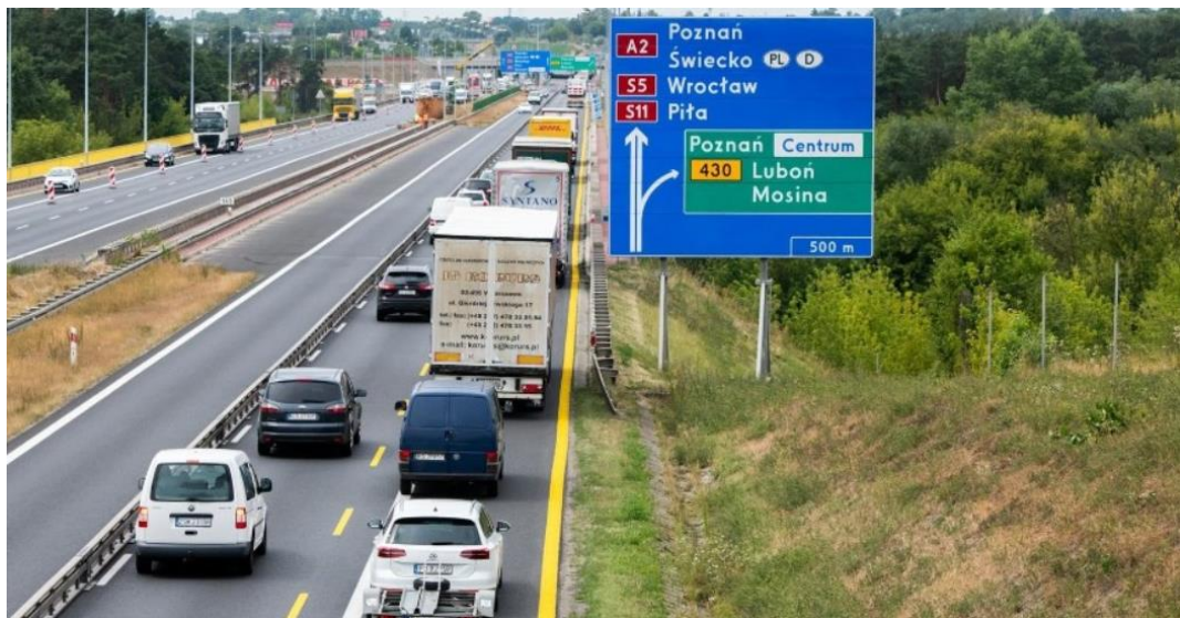
Rys. 7.25 Poznań BY - PASS A2 – Odcinek południowej obwodnicy autostradowej m. Poznania – podczas rozbudowy, 2019 rok
