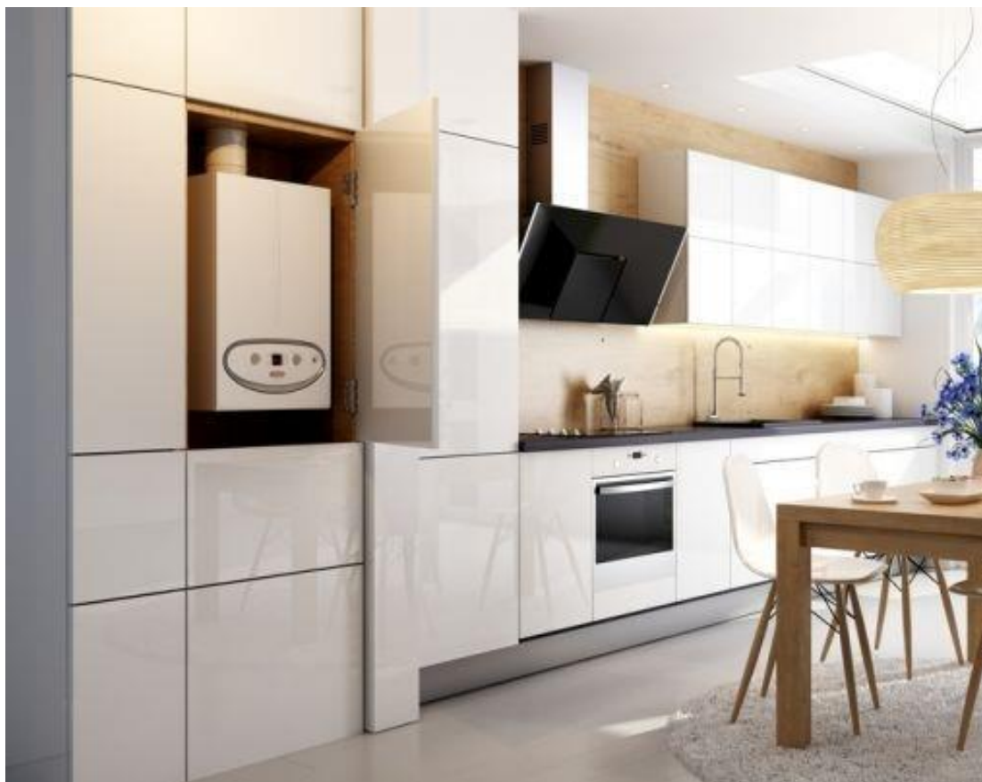
Ilustracja 86. Przykładowe wnętrze z kotłem gazowym [Źródło: https://www instalacjebudowlane.pl/4182-23-40-gdzie-umiescic-kociol-grzewczy.html , 13.01.2022r]. dostęp
