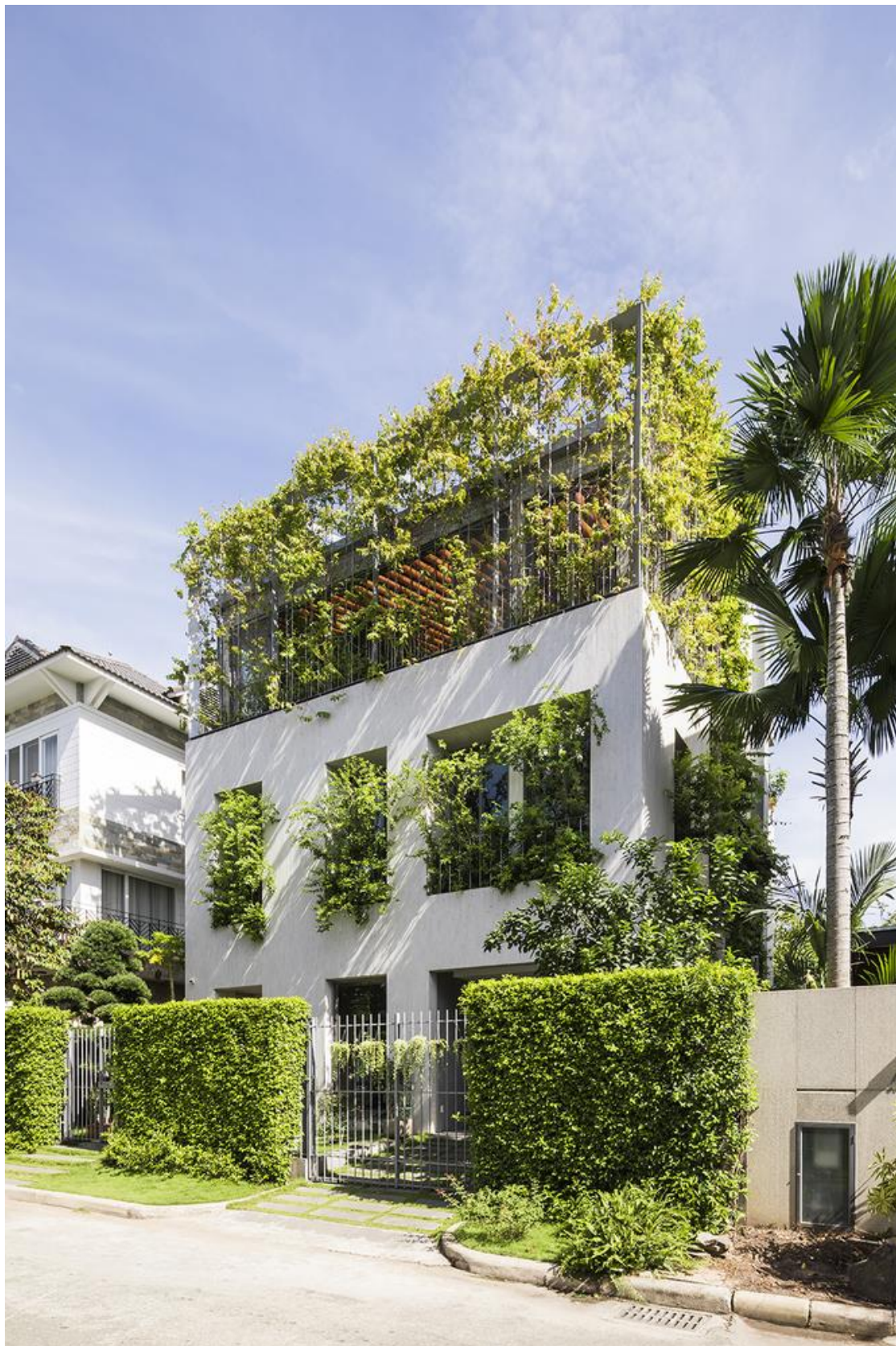
Ilustracja 33. Stepping Park House [źródło: https://www.archdaily.com/908346/stepping-park-house-vtn-architects/5c20fbc08a5e516a3001606-stepping-park-house-vtn-architects-photo?next_project=no , dostęp 07.01.2022r.].
