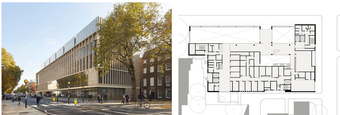
Europa: The Zayed Centre for Research into Rare Disease in Children (proj. Stanton Williams, Wielka Brytania 2019 r.) Fot. 9. (po lewej) Widok na elewację frontową szpitala. Źródło: stantonwilliams.com Rys. 31. (po prawej) Rzut obiektu. Źródło: Archdaily
