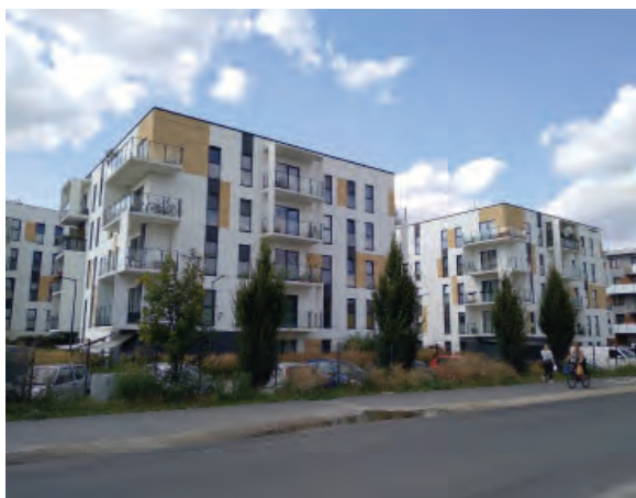
Ryc. 25. Budynek mieszkalny przy ul. Jasielskiej w Poznaniu wykonany w technologii żelbetowej prefabrykowanej. Proj. Mikulicz Architekci. [źródło: fot. aut.]
